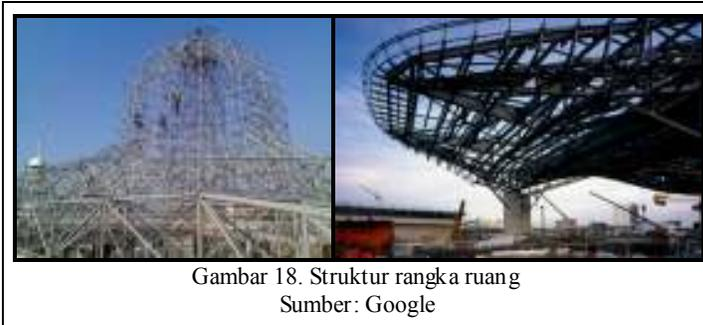
Gambar 18. Struktur rangka ruang
