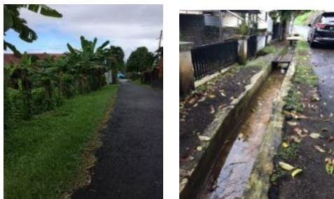
Gambar 2. Kondisi Eksisting Drainase
