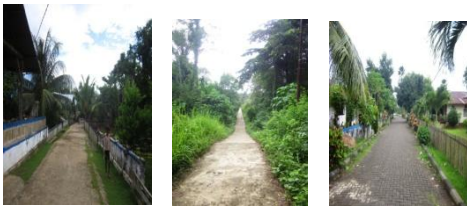
Gambar 8 Kondisi Jalan di P.Mantehage : Sumber : observasi lapangan
