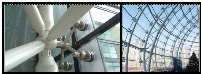
Gambar Struktur Selubung dengan menggunakan spider-glass dan space-frame (tipe Stressed skin systems )
