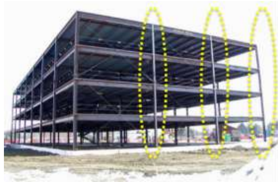
Gambar 1. Batang Tekan Kolom Struktur
