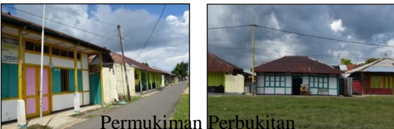
Gambar 4.11 Kondisis Eksisting Permukiman di Pulau Doo Kota Sorong Sumber : Penulis, 2016
