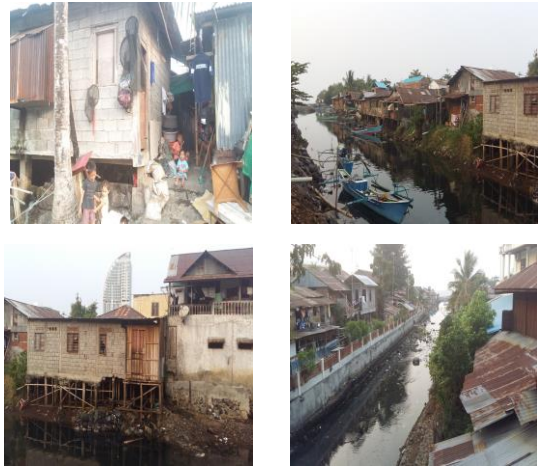
Gambar 12. Kondisi Bangunan dan Permukiman di Kel. Bahu
