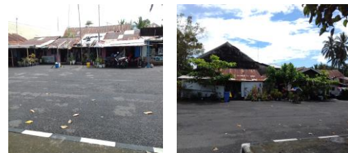
Gambar 13. Kondisi Bangunan dan Permukiman di Kel. Bitung Karang Ria
