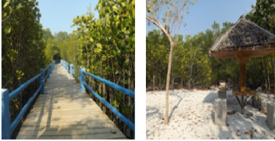
Kondisi Jembatan dan Gazebo pada Ekosistem Mangrove di DPL Desa Bahoi
