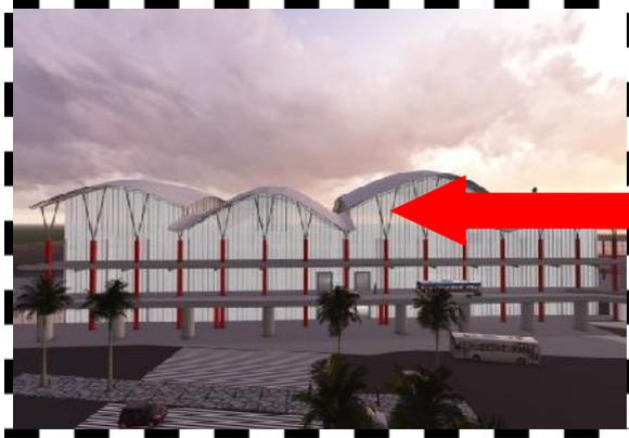
Mengoptimalkan dan mengaplikasi struktur space frame ke dalam bentuk yang berkesan dinamis seperti geleombang air laut
