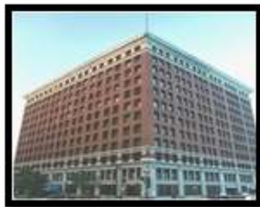
Penggunaan material baja sebagai struktur dan bata bata sebagai dinding nya bisa meminimalisas keran klob pada bangunan sehingga bisa menahan beban angin yang ada.
