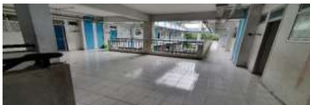
Gambar 12. Ruang Kosong Rumah Susun Sewa Cakalang di Bitung.
