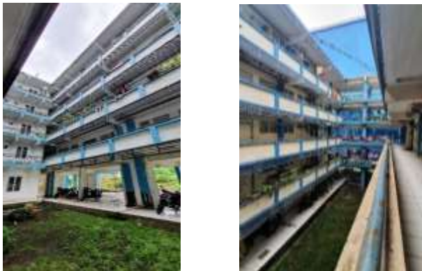
Gambar 9. Bukaan Void Rumah Susun Sewa.
