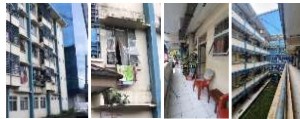
Gambar 7. Bukaan Rumah Susun Sewa Ringroad di Manado
