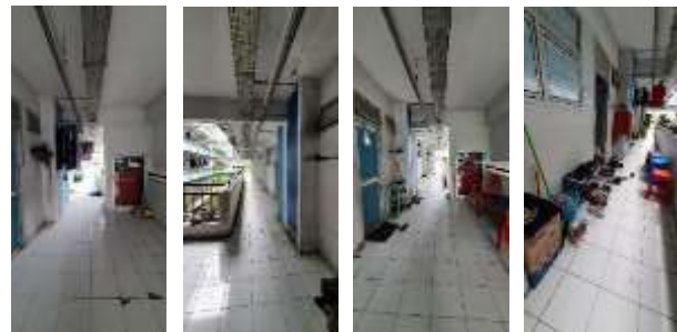
Gambar 5. Koridor / Selasar Susun Sewa Cakalang di Bitung.
