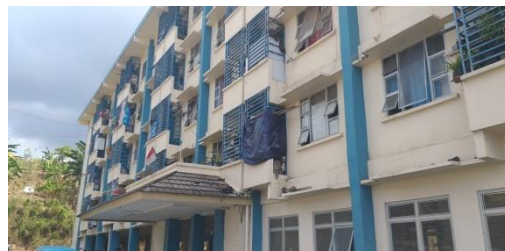
Gambar 4.3 Rusunawa Tingkulu Sumber: Dokumentasi Peneliti
