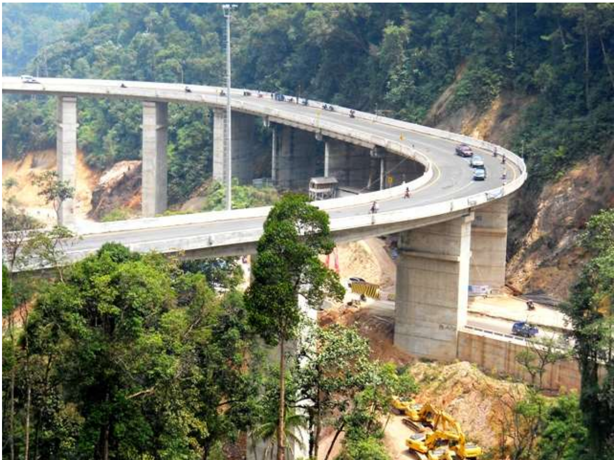
Gambar 7. Jalan layang yang dibuat untuk mendapatkan desain alinyemen vertikal dan tikungan yang sesuai dengan standar oleh karena kondisi terrain bergunung. Sumber : Ruas Jalan Kelok Sembilan, 2014.
