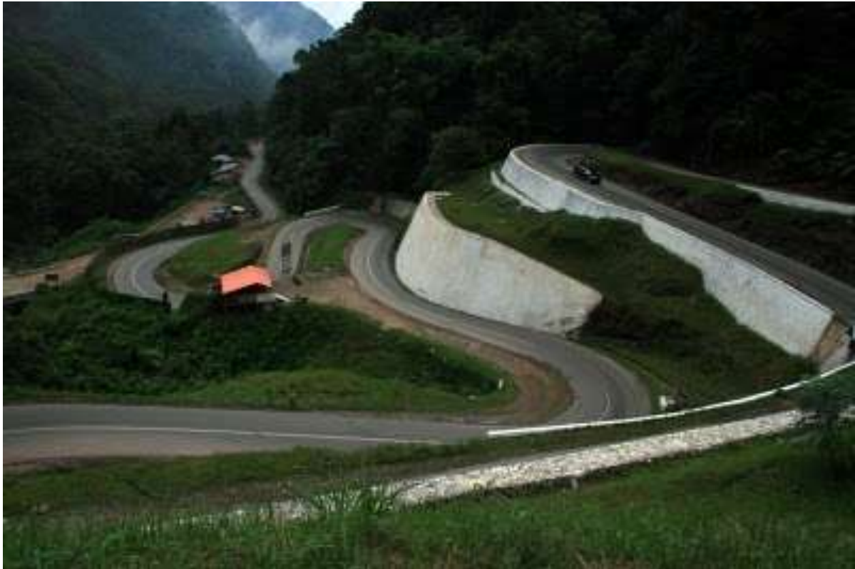
Gambar 9. Struktur penahan tanah yang mumpuni untuk menahan lereng di atas dan di bawah jalan. Sumber : ruas Jalan Kelok Sembilan, 2014.
