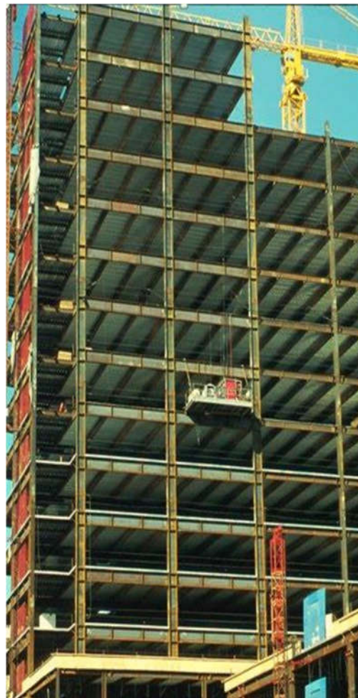
Gambar 2 Sistem Struktur Rangka Baja (Sumber: angryits.blogspot.co.id/sistemstrukturrangkabaja )
