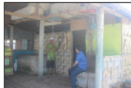
Gambar 3 Kolom beton Sumber: Hasil Observasi, 2016
