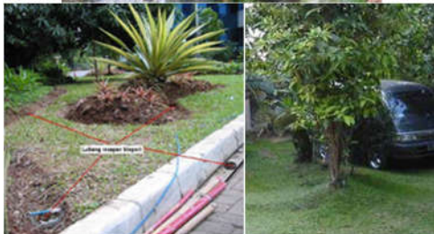
Gambar 4 LRB pada dasar saluran, batas taman dan sekeliling pohon
