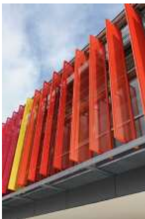
Gambar 1. Pemasangan sirip matahari pada Sekolah Dasar di Neubiberg-Jerman 1
