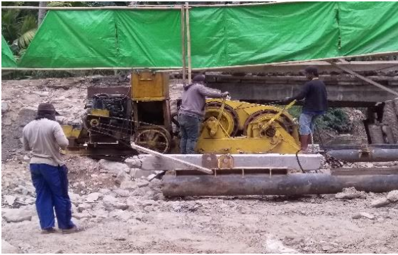
Gambar 17. Mensetting Mesin Pancang
