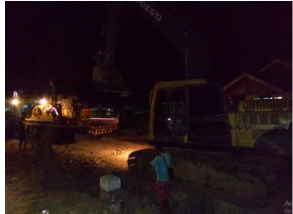
Gambar 16. Proses penurunan alat pancang
