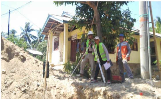
Gambar 11. Proses pengukuran dan penentuan titik-titik tiang pancang yang akan dipancang
