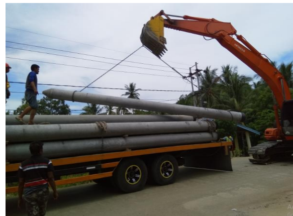
Gambar 13. Proses penurunan tiang pancang
