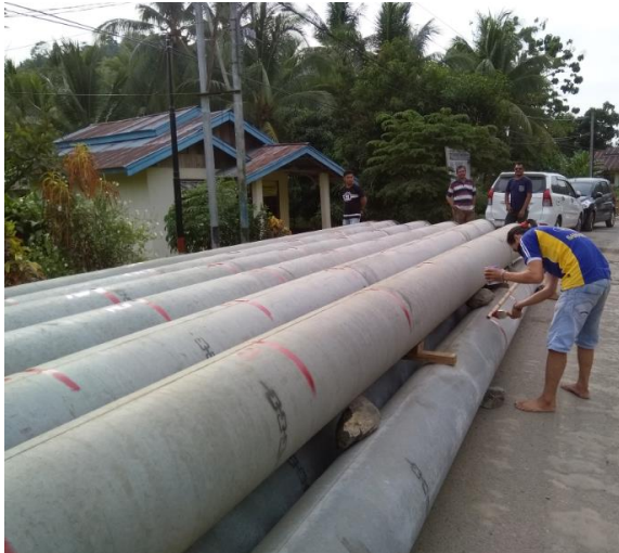
Gambar 14. Pengecetan tiang pancang
