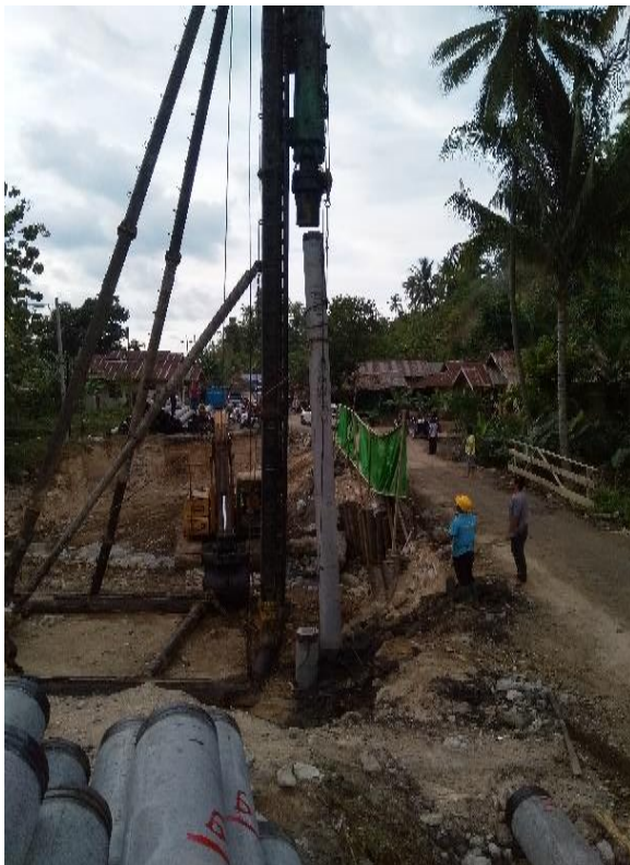
Gambar 27. Proses memasukkan kepala tiang pancang ke topi
