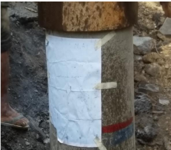
Gambar 32. Proses pembacaan kalendering
