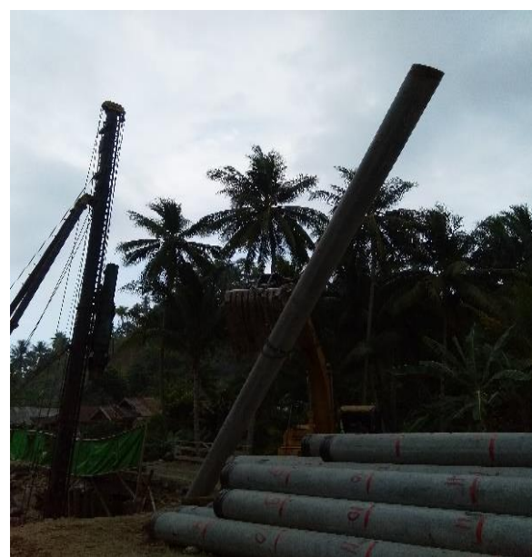
Gambar 25. Tiang Pancang dibawa ke Titik Pancang
