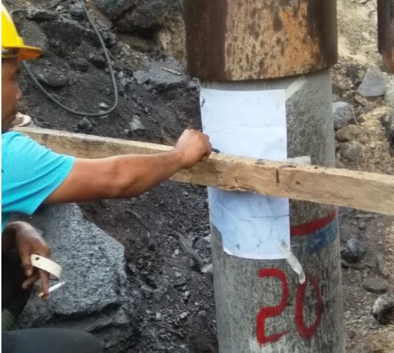
Gambar 31. Proses penulisan kalendering
