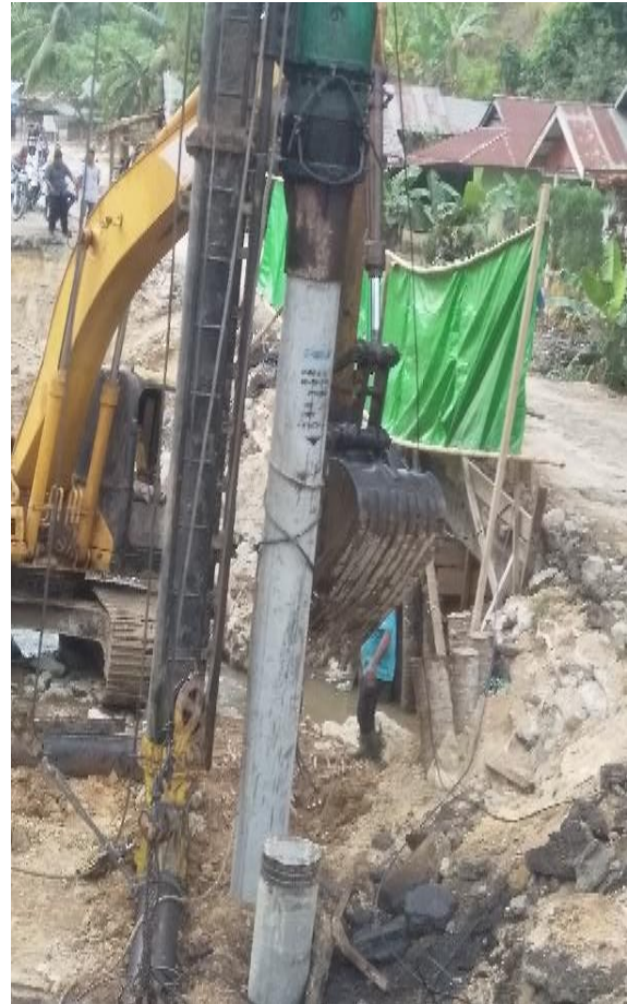
Gambar 28. Proses pemancangan
