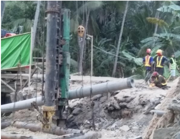
Gambar 26. Tiang Pancang diikat dengan labrang
