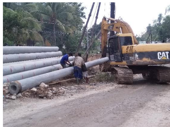
Gambar 24. Pengangkatan Tiang Pancang Panjang 8 m ( Bottom)
