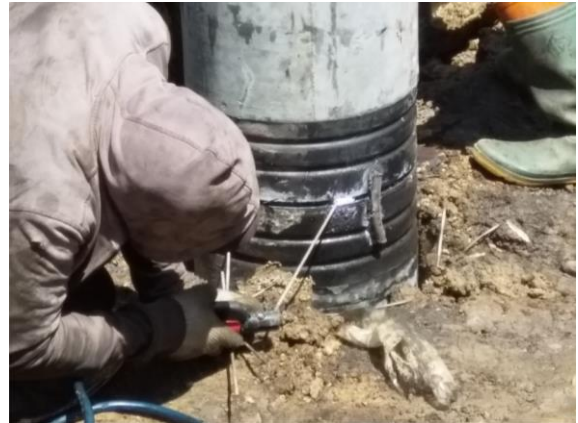
Gambar 30. Proses pengelasan sambungan tiang pancang Bottom dan tiang pancang Upper
