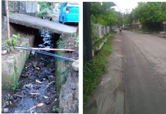
Gambar 2. Kondisi eksisting drainase
