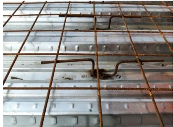
Gambar 14. Pemasangan wiremesh
