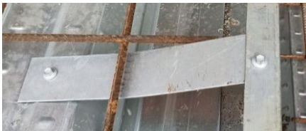
Gambar 12. Pemotongan endstop
