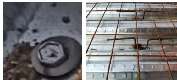
Gambar 11. Bout Pada Bondek
