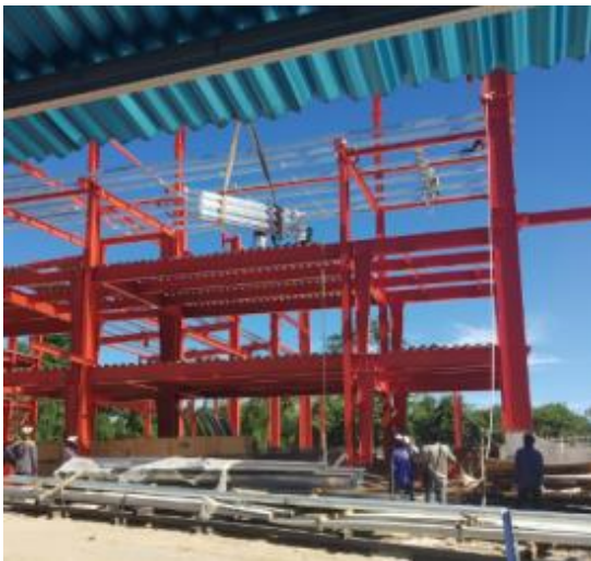
Gambar 9. Pengangkatan bondek
