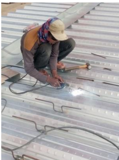
Gambar 13. Proses las wiremesh
