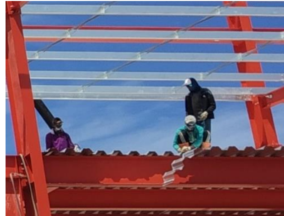
Gambar 10. Pemotongan Bondek
