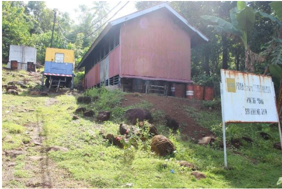
Gambar 4. Pembangkit Listrik di Pulau Nain
