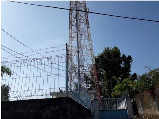
Gambar 6 Jaringan Telekomunikasi di Kawasan Sekitar Jalan Lingkar Sumber : Hasil Survei, 2018
