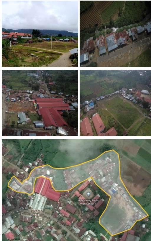
Gambar 22. Lokasi Terjadinya Banjir Sumber: Penulis, 2018
