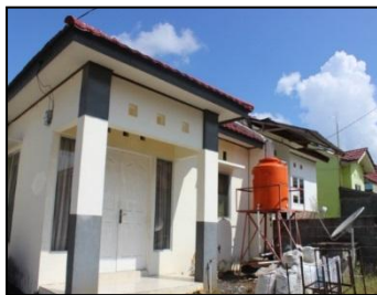
Gambar 10. Kondisi Sistem Penyediaan Air Perumahan Lembah Nyiur Kairagi Mas Sumber: Survey Lapangan, 2015
