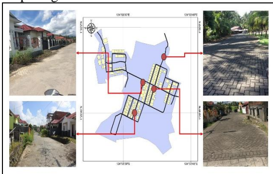
Gambar 15. Kondisi perumahan yang tidak memiliki jalur hijau jalan
