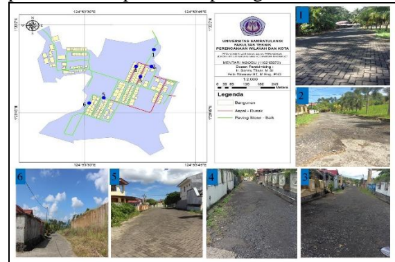
Gambar 7. Kondisi jalan Perumahan Lembah Nyiur Kairagi Mas
