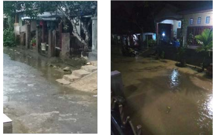
Gambar 1. Kondisi Eksisting dan Kondisi Ruas Tanpa Saluran
