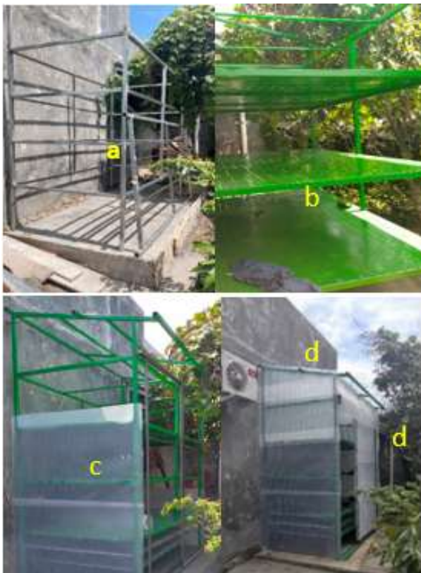
Gambar 5. Proses Pembangunan alat pengeringan disamping Gedung UMKM Biovina yang dibangun sekitar 2x4 m yang terbuat dari rangka besi tahan karat (a) dan alas pengeringan dengan stainless steel berlobang (b) dengan dinding dan atap tembus pandang, mudah dibersihkan dan tidak bisa dimasuki serangga pengganggu (c), dengan pintu yang lebar bisa dibuka lebar dan bisa terkunci dengan baik (d).
