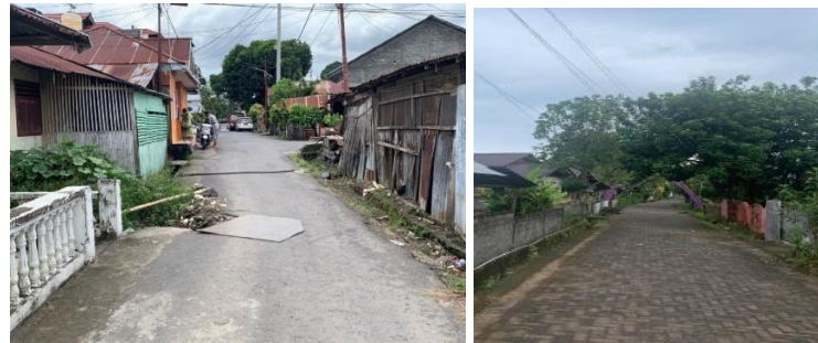
Gambar 3. Kondisi Jalan Lingkungan Lokasi Penelitian (Penulis, 2022)
