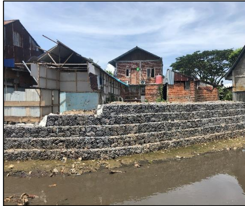
Gambar 11. (a)Pemasangan batu kali Pembangunan tanggul pada Sungai Bailang (Penulis, 2023)
