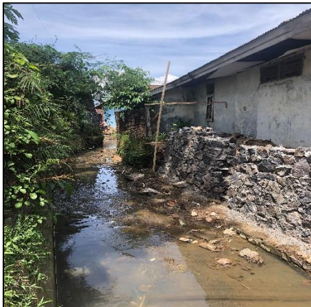
(a) perbaikan drainase kelurahan bailang
