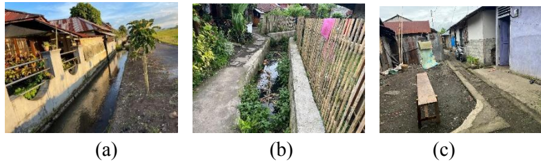
Gambar 9. Infrastruktur Drainase (a) baik (b) memerlukan pemeliharaan (c) tidak ada drainase (Dokumentasi Peneliti, 2024)
