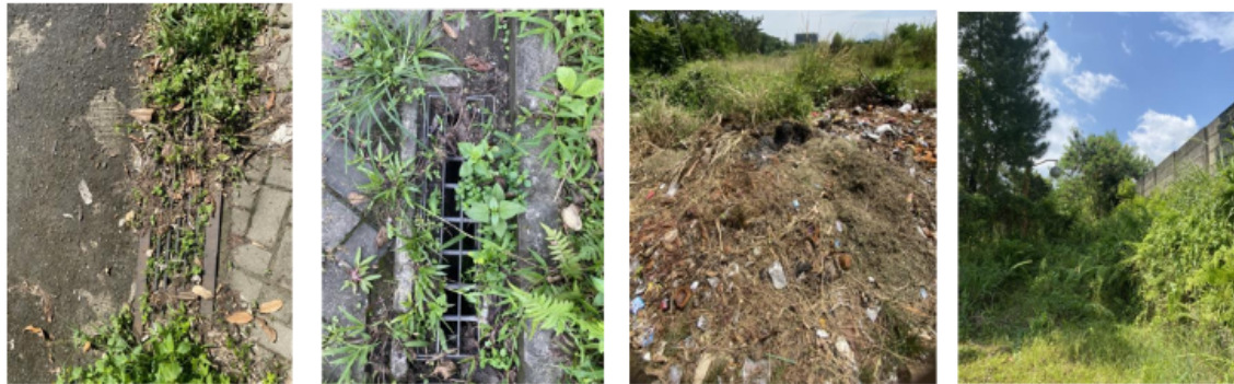
Gambar 3. Kondisi Drainase, Sampah, dan Pintu Masuk yang tidak terawat
