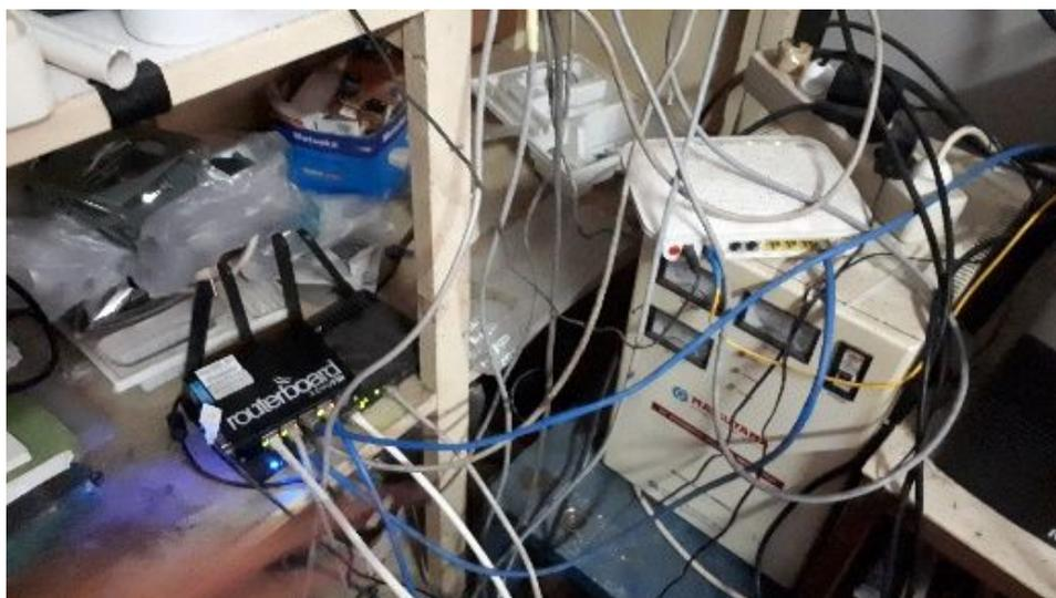
**Gambar 5.** Perangkat router, core switch, beserta perangkat pendukung lainnya.
