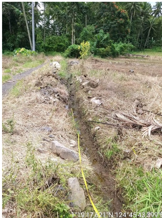
Gambar 3. Kondisi saluran irigasi eksisting
