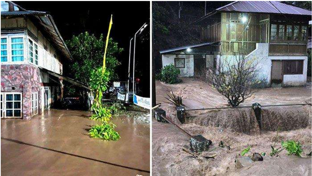
Gambar 1. Kondisi Banjir Desa Ranowangko II Sumber: Dokumentasi Desa, 2024
