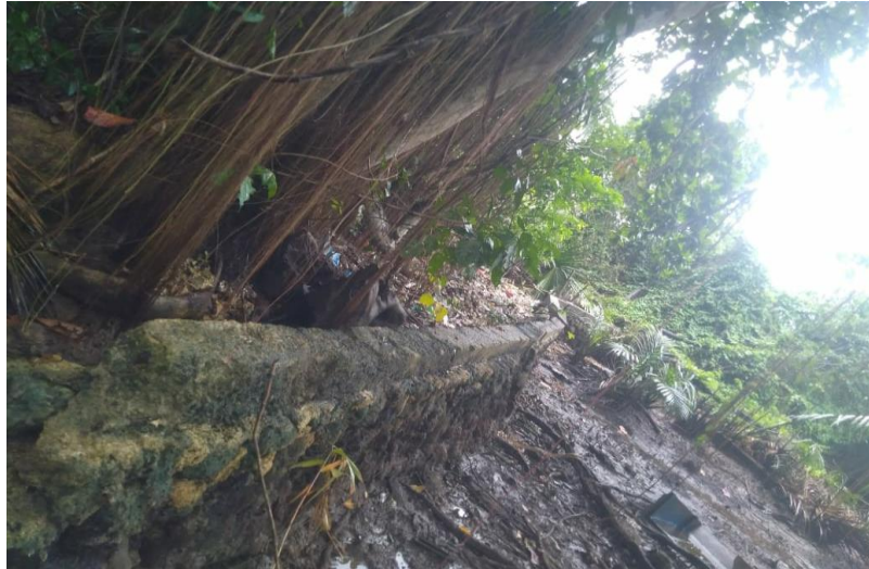
Sumber : Foto Penelitian Gambar 1. Penahan Gelombang di Desa Buhias
