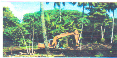
Gambar .2 Kolam yang sementara dibangun dengan menggunakan Excavator (kolam F).
