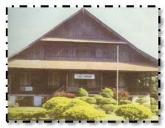
Terletak di halaman seluas 80 x 110 meter loji itu berukuran 20 x 30 meter. Berdiri di atas beton cor setinggi 110 Cm. Kayu yang digunakan kayu wasian, sejenis cempaka.
