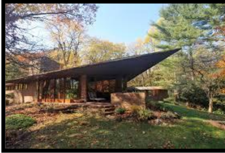
Gambar 5 tampak bangunan Palmer House
