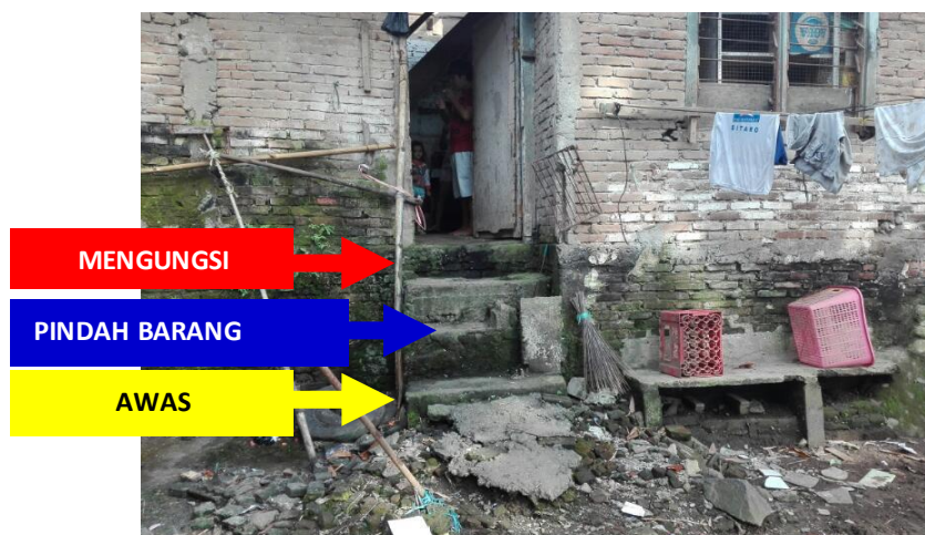
Gambar 3 Bagian rumah yang dijadikan tanda awas banjir.
