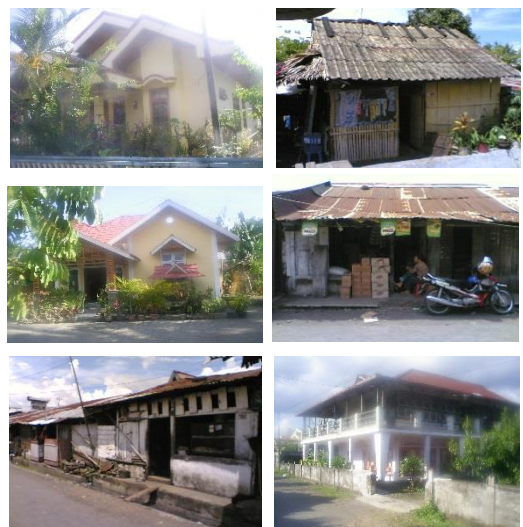
Gambar 2. Kondisi Bangunan dan lingkungan
