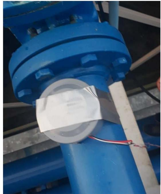
Gambar 12 Peletakan sensor MLX90614 di pipa karbonsteel
