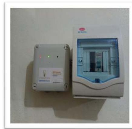
Gambar 7. Pemasangan *Smart meter*
