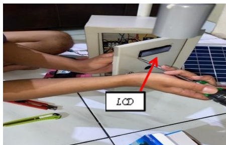
Gambar 7. Pemasangan Sensor Tegangan LCD
