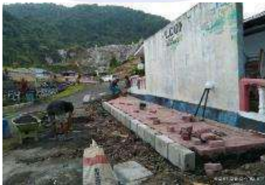
Gambar. Pembangunan Jalan Paving
