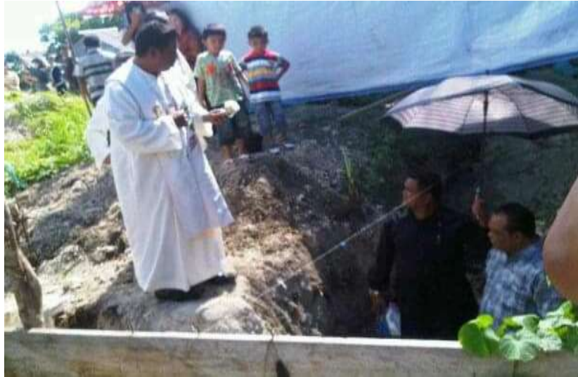
Gambar: Pemasangan Batu Pondasi untuk gereja baru Sumber: Dokumen Pribadi
