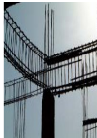
Foto 17. Kolom Pinggir tidak dijangkar ke kolom
