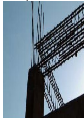
Foto 17. Kolom Pinggir tidak dijangkar ke kolom
