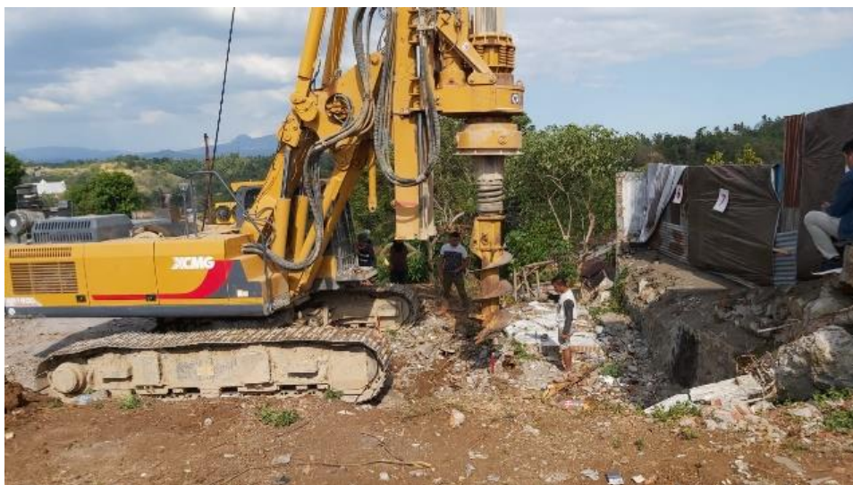
Gambar 10. Proses Pengeboran Titik Pondasi Bore Pile
