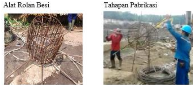
Gambar 7. Perakitan Tulangan Sengkang
