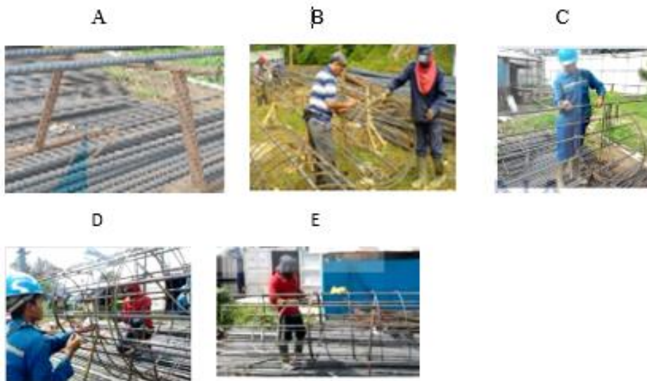
Gambar 8 Perakitan Tulangan Utama Bore Pile
