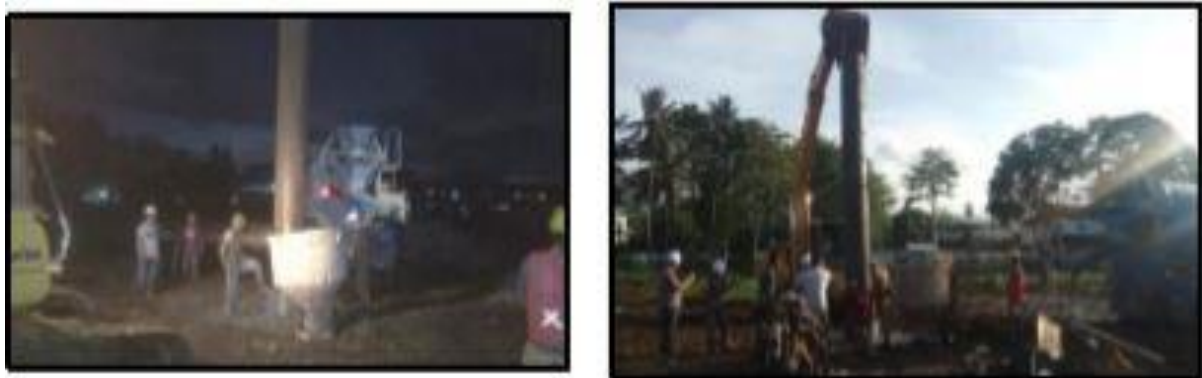
Gambar 13. Proses Pengangkatan Temporary Casing
