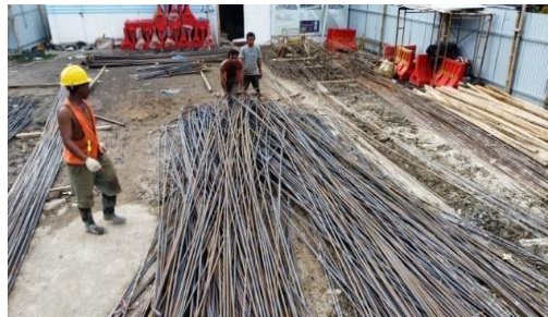
Gambar 3.9 Besi Yang Akan Di Prabikasi Besi Ulir D16 dan D10
