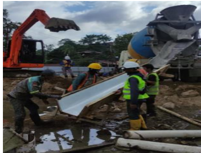
Gambar 3.13 Perakitan Jalur Pengecoran
