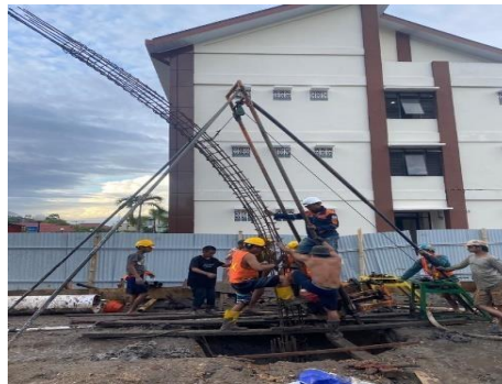
Gambar 3.11 Pemasukkan Penulangan Besi
