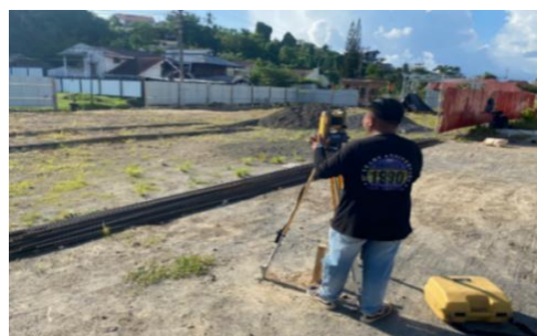
Gambar 3.6 Penentuan Titik Pondasi Bored Pile
