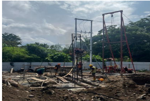
Gambar 3.8 Pengeboran Dengan Dua Alat Wash Boring
