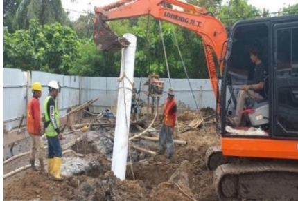
Gambar 3.15 Pengangkatan Pipa Casing
