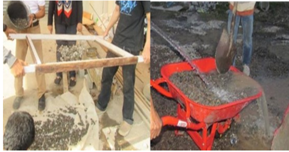
Gambar 4. Penyaringan dan Pencucian Agregat
