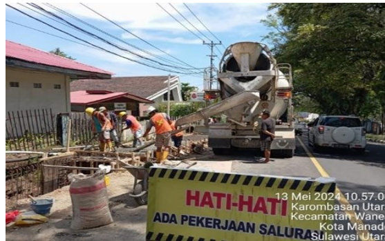
Gambar 16. Pengecoran Sambungan U-Ditch
