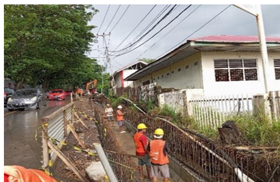
Gambar 15. Penyambungan Setiap Unit U-Ditch
