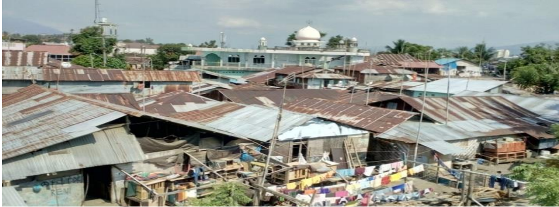
Gambar 3. Kondisi Fisik Bangunan
