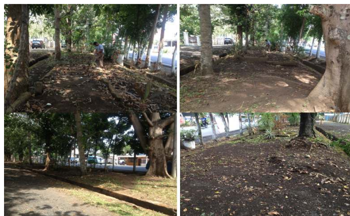
Gambar 5 Pembersihan Lokasi dan Persiapan Pembuatan Taman
